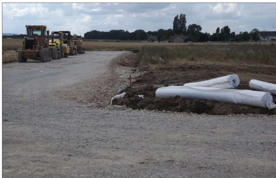
■ Les engins de terrassement ont investi les futures rues de la zone.
